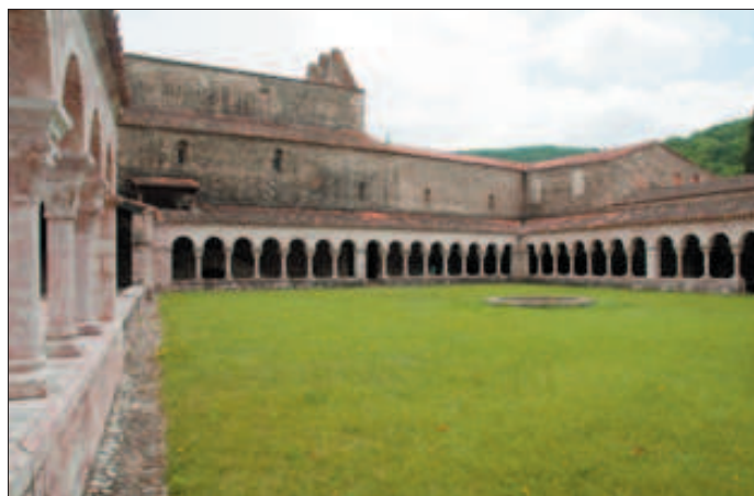
Vista de les dues naus que queden del claustre, el que falta es troba al museu dels Cloisters a New York.
