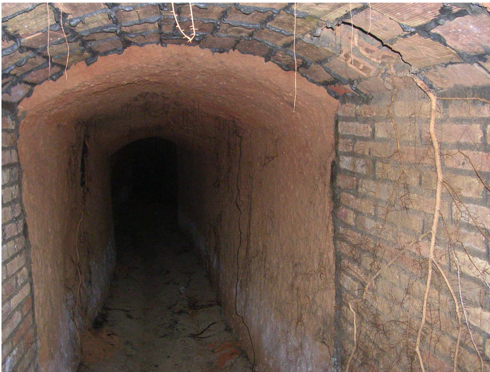
Aspecte actual de l'interior del refugi antiaeri de l'Ateneu.
