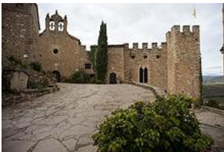
Vista del Castell de Montsonís
