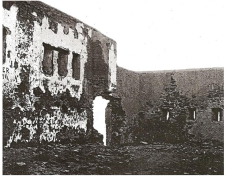
Interior del fortí de Sant Pere Màrtir en ruïnes.
